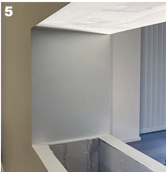
5 Pejsevæg lukket i top og sider / The fireplace wall closed at the top and sides.
